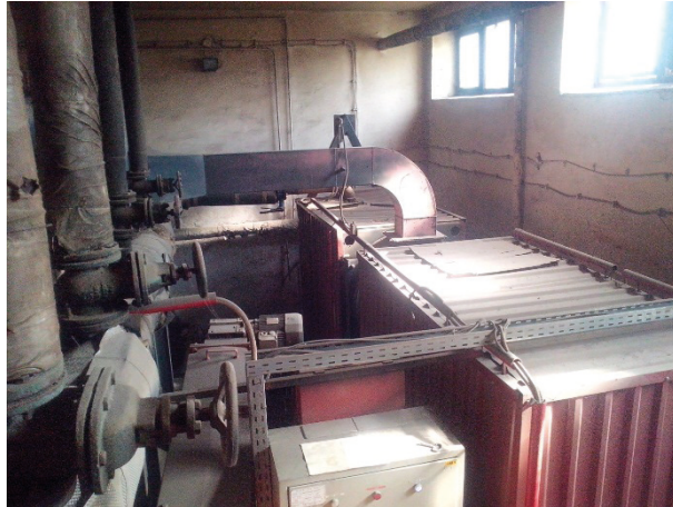
2. kép: A legnagyobb 600 KW-os kazán az iskolában Forrás: Saját készítés
