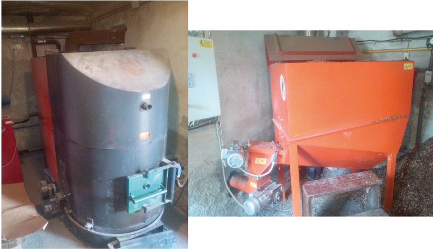
3. kép: Teljesen automatikus 80 KW-os kazán (napközi)
